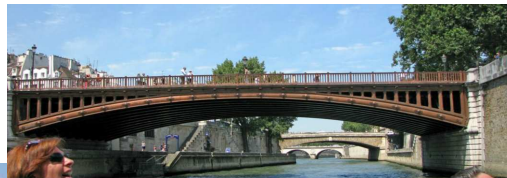
Pont au Double (45x20m. sustitución 1883 hierro fundido)
